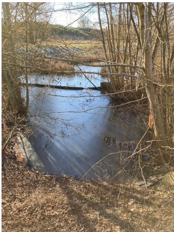
Ansicht auf den Zulauf:
